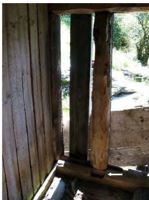
Ill. 13 : Echancrure faite au pied d'une paroi de séparation dans le seuil de la porte d'une grange-écurie et témoignant de la petitesse de la partie du bâtiment possédée
