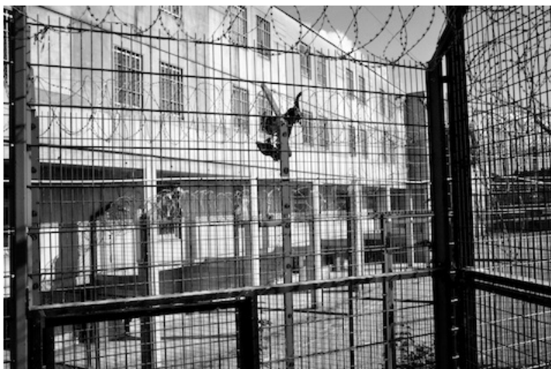
Fig. 4 : grillages de la cour de promenade.
